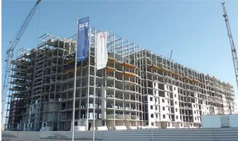
*По современной строительной технологии сначала возводится каркас здания, а затем он "одевается" в стены. После этого внешне дом выглядит, как объем, представляющий собой чередование поверхностей и проемов в них.*
